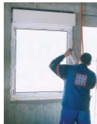
Najprije se štok namjesti u otvor i specijalnim vijcima učvrsti u zid, fuga se popunjava pur pjenom, te se namješta krilo sa staklom
